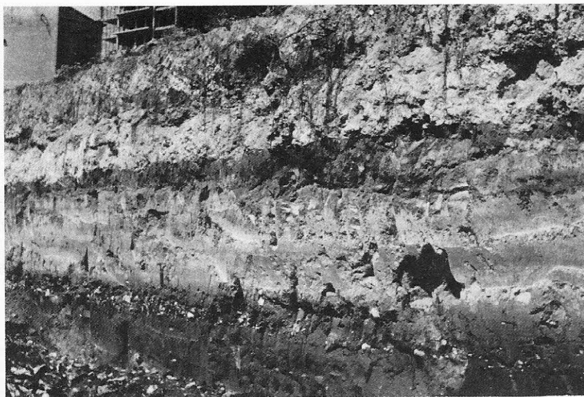
Fig. 3 — Un aspetto della parte bassa della Calcarenite di Gravina alla periferia di Bari. Sulla parete di uno scasso per fondazioni, dal basso si distinguono le terre rosse con ciottoli calcarei passanti ai silts calcareo-argillosi, i quali a loro volta passano alle biocalcareniti. La successione è coperta da circa 1 m di terreno di riporto.
