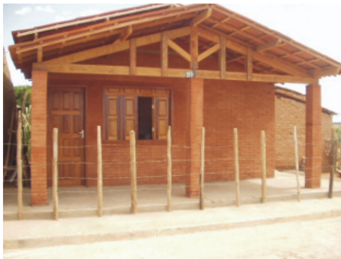
Ilustração 9 – Casa de tijolo de solo-cimento em fase final, feita pelos próprios moradores Crédito: Clovis, 2004
