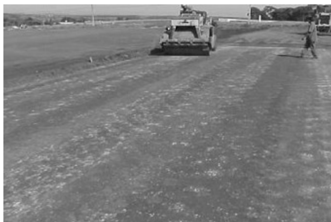
Figura 6 - Base executada com agregado reciclado de RCD, Goiânia (Fonte: SILVA, 2004)
