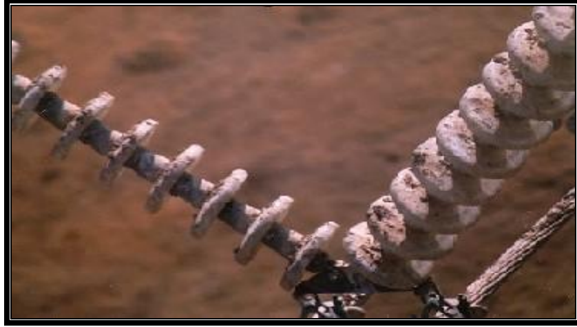
الشكل (١) يبين شدة التلوث التي تتعرض له اسطح العوازل
