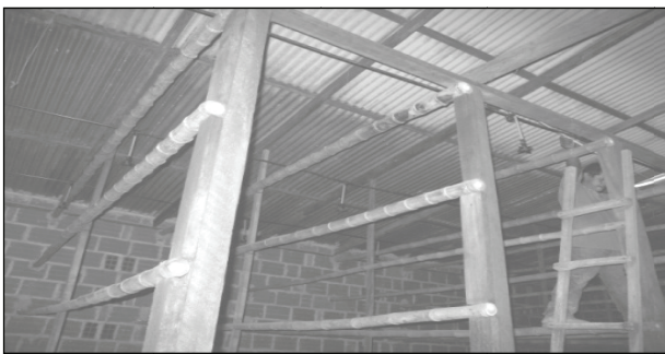
Figura 1. Instalación de los nebulizadores Fogger Figure 1. Installing fogger nebulisers
