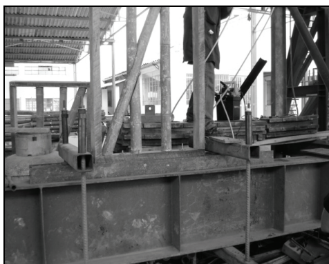
Figura 3. Montaje de los paneles
