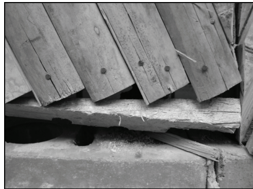
Figura 27. Desgarramiento de la solera inferior
