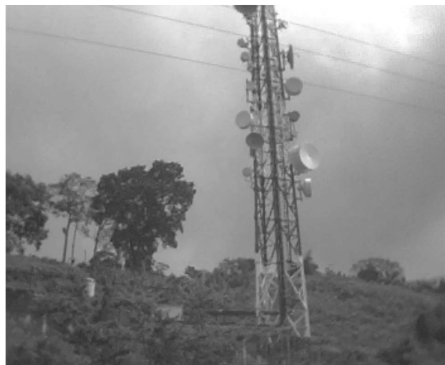
Figura 16. Mediciones realizadas en la zona de transmisores.
