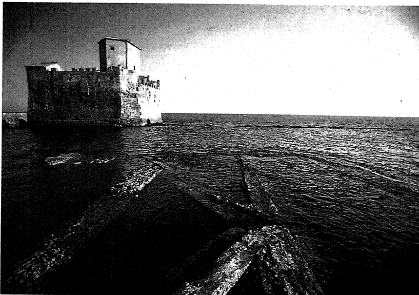
Foto 10 - Torre Astura: semisommersa dal mare si vede la pianta originale della piscina di allevamento.
