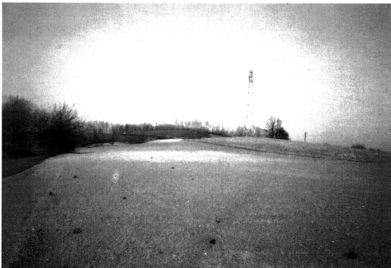
Fig. 9 - Estesi subaffioramenti nell'area di distribuzione dell'Unità di Buttigliera.
