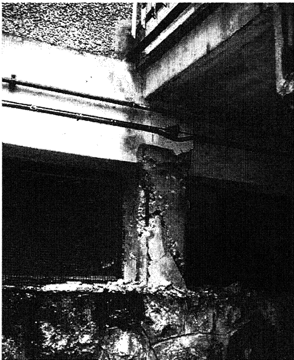
Figura 6 – Castelluccio inferiore (VI). Rottura del pilastro tozzo nel retro della palazzina di Fig. 5.
