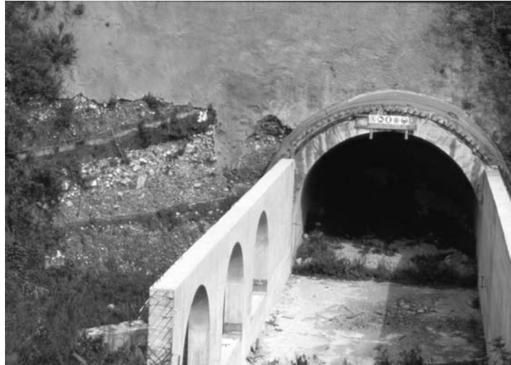
Fig. 8 - Ingresso della galleria ANAS in costruzione che attraversa il valone di Foiano. Sulla sinistra sono ben evidenti i depositi di conoide alternati a livelli piroclastici tardo pleistocenici.
