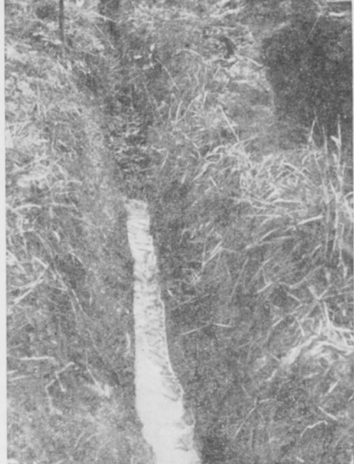
Kuva 12. Sama koe kuin kuvassa 11. Noin 90 m:n päässä, ojan alapäässä tulee sepelikerroksesta leveä vesivirta.
