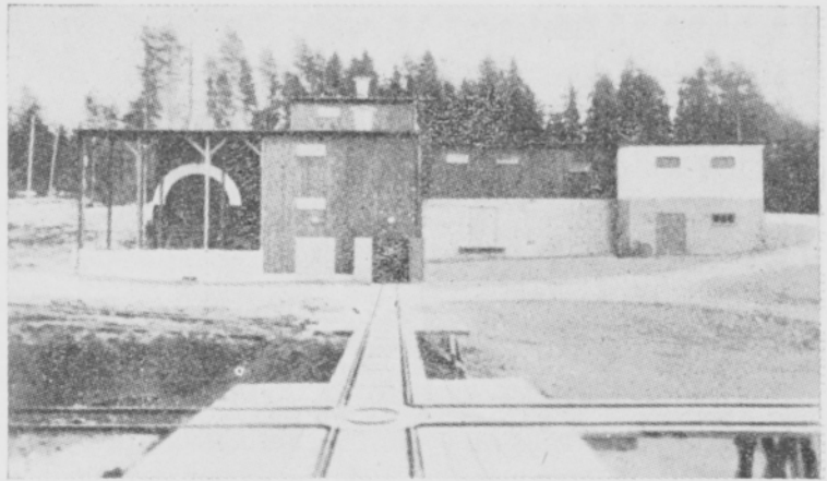
Kuva 2. Puhtaanapitojätteen kompostoimislaitos Karlskoga Ruotsissa. Vasemmalla pyörivän egsetor-rummun pääty; kuivan jätteen käsittelyyn ei tarvita muuta. Oikealla latriinipönttöjen vastaanotto, sulatusosasto (talvella), tyhjennys ja pesu. Keskellä latriinin homogenisointi- ja kompostin sekoituskoneistot. Etualalla kompostin varastoimisalue.
